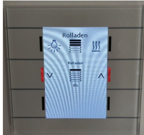
Abbildung 6: Taster (Sensor) des Herstellers MDT
